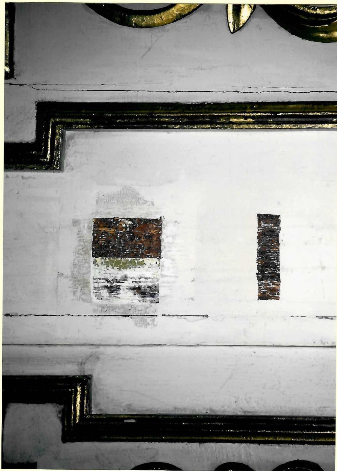
Fot. 6. Biały Kościół. Kościół parafialny p.w. Św. Mikołaja. Prospekt organowy i empora chóru muzycznego. Fragment balustrady empory. W odkrywce widoczne dwa przemalowania olejne i pierwotna malatura w kolorze brunatno czerwonym. Stan zachowania przed konserwacją Fot. Antoni Guzik, 2021.
