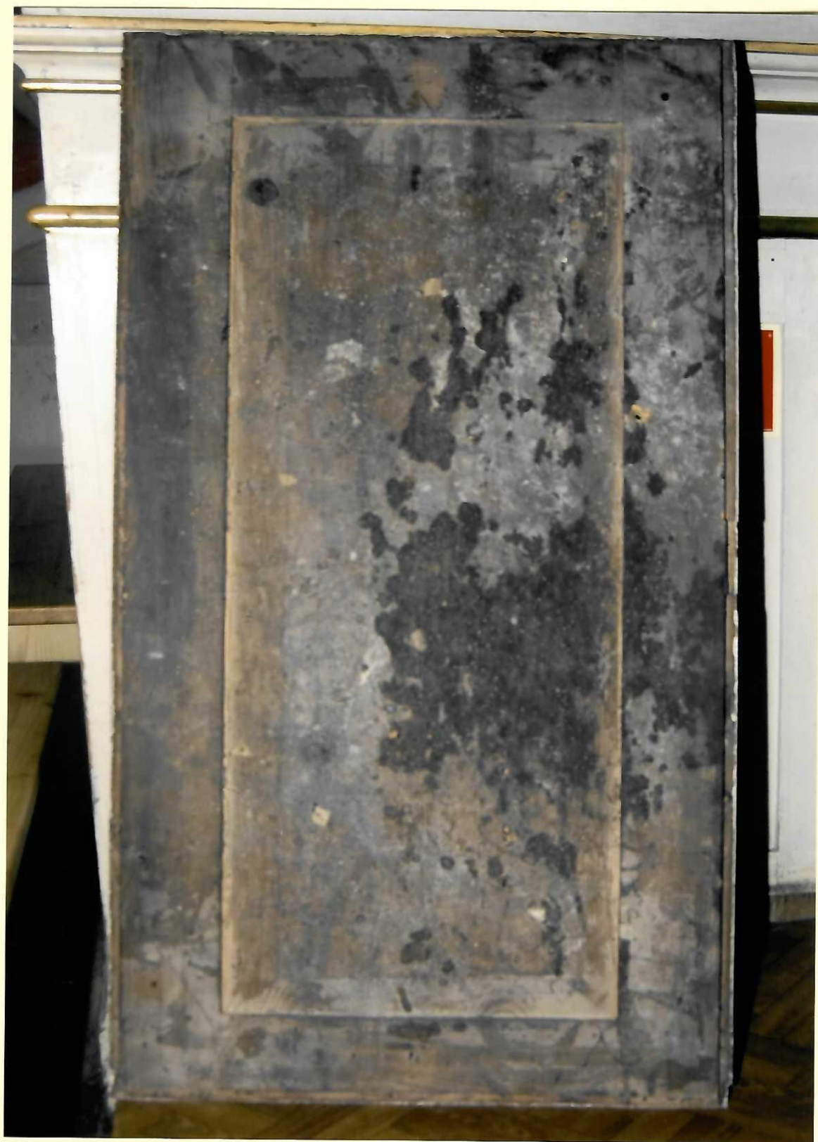
Fot. 10. Biały Kościół. Kościół parafialny p.w. Św. Mikołaja. Prospekt organowy i empora chóru muzycznego. Odwrocie filunku szafy organowej. Widoczne wykwity spowodowane działalnością mikroorganizmów (pleśń). Stan zachowania przed konserwacją Fot. Antoni Guzik, 2021.
