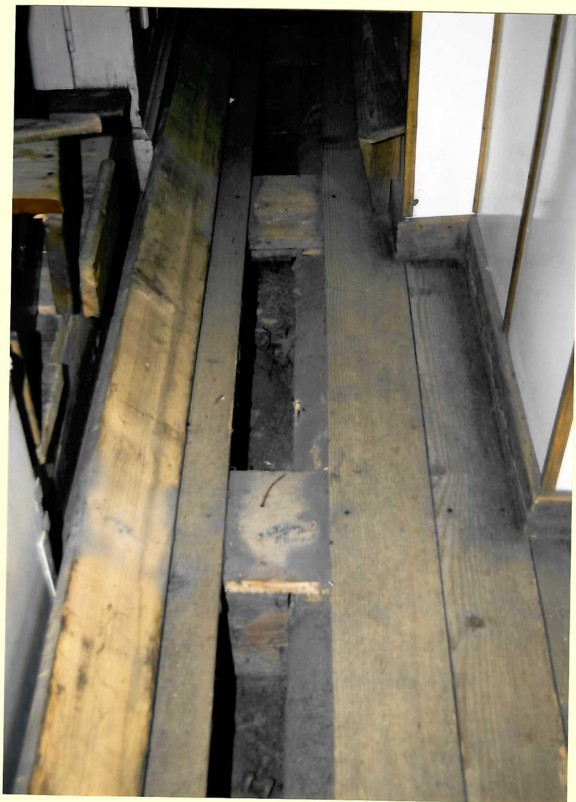
Fot. 7. Biały Kościół. Kościół parafialny p.w. Św. Mikołaja. Prospekt organowy i empora chóru muzycznego. Podłoga empory. W odkrywce widoczne belki konstrukcyjne empory. Stan zachowania przed konserwacją Fot. Antoni Guzik, 2021.
