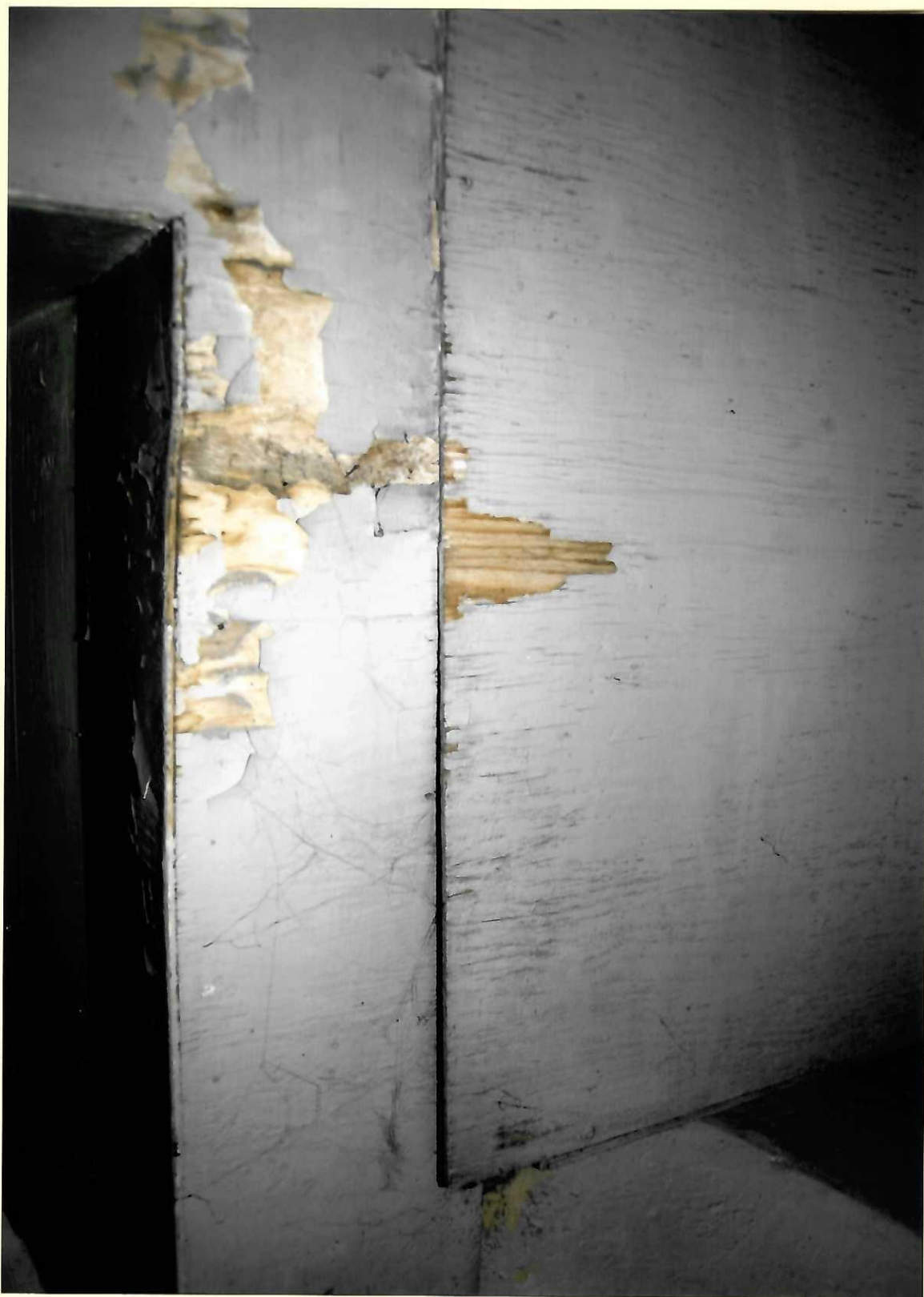
Fot. 12. Biały Kościół. Kościół parafialny p.w. Św. Mikołaja. Prospekt organowy i empora chóru muzycznego. Fragment obudowy szafy organowej. Widoczna wymiana wykonana z sklejki drewnianej. Stan zachowania przed konserwacją Fot. Antoni Guzik, 2021.
