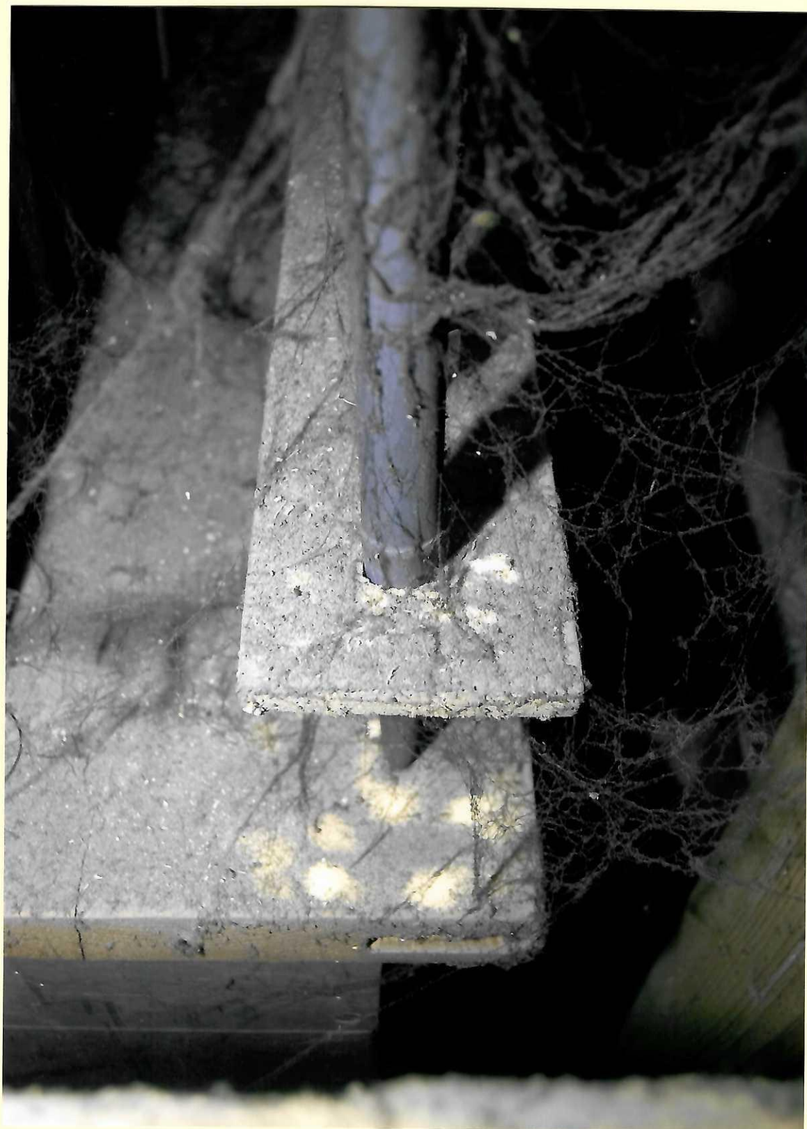
Fot. 11. Biały Kościół. Kościół parafialny p.w. Św. Mikołaja. Prospekt organowy i empora chóru muzycznego. Fragment wiatrownicy instrumentu organowego. Widoczne świeże kopczyki pyłu drzewnego – produktu metabolizmu, czynnych owadzych szkodników drewna. Stan zachowania przed konserwacją. Fot. Antoni Guzik, 2021.
