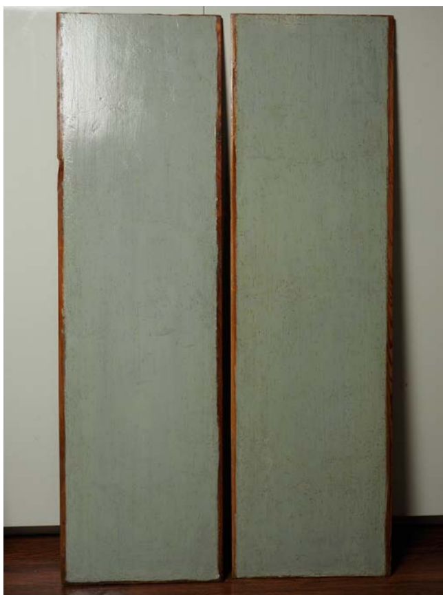
Przykładowe fragmenty lewej szafy organowej po konserwacji – po odśłonięciu pierwotnej błękitno-bordowej polichromii, impregnacji drewna i wykonaniu uzupełnień ubytków drewna kitami drewnopodobnymi, warstwę malarską zabezpieczono werniksem i uzupełniono warstwę malarską metodą naśladowczą do oryginału.
