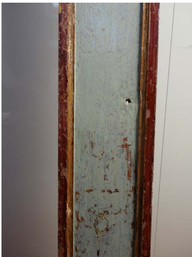
Fragmenty lewej szafy organowej w trakcie konserwacji – po odstąpieniu pierwotnej błękitno-bordowej polichromii, impregnacji drewna i wykonaniu uzupełnień ubytków drewna kitami drewnopodobnymi, warstwę malarską zabezpieczono werniksem i rozpoczęto uzupełnianie – retusz warstwy malarskiej metodą naśladowczą do oryginału.
