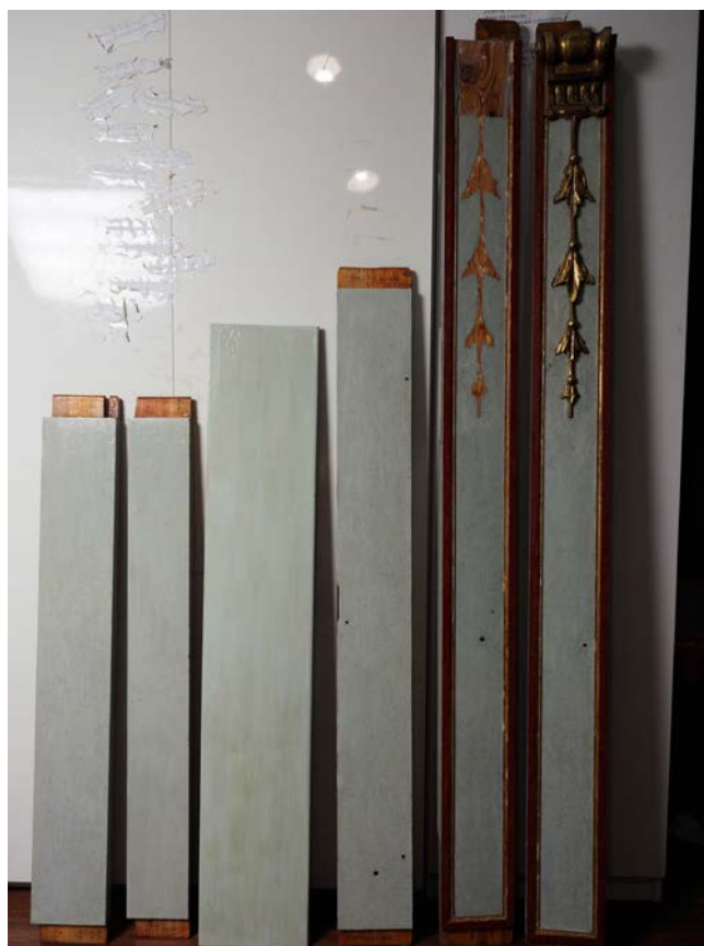
Przykładowe fragmenty lewej szafy organowej po konserwacji – po odśłonięciu pierwotnej błękitno-bordowej polichromii, impregnacji drewna i wykonaniu uzupełnień ubytków drewna kitami drewnopodobnymi, warstwę malarską zabezpieczono werniksem i uzupełniono warstwę malarską metodą naśladowczą do oryginału.
