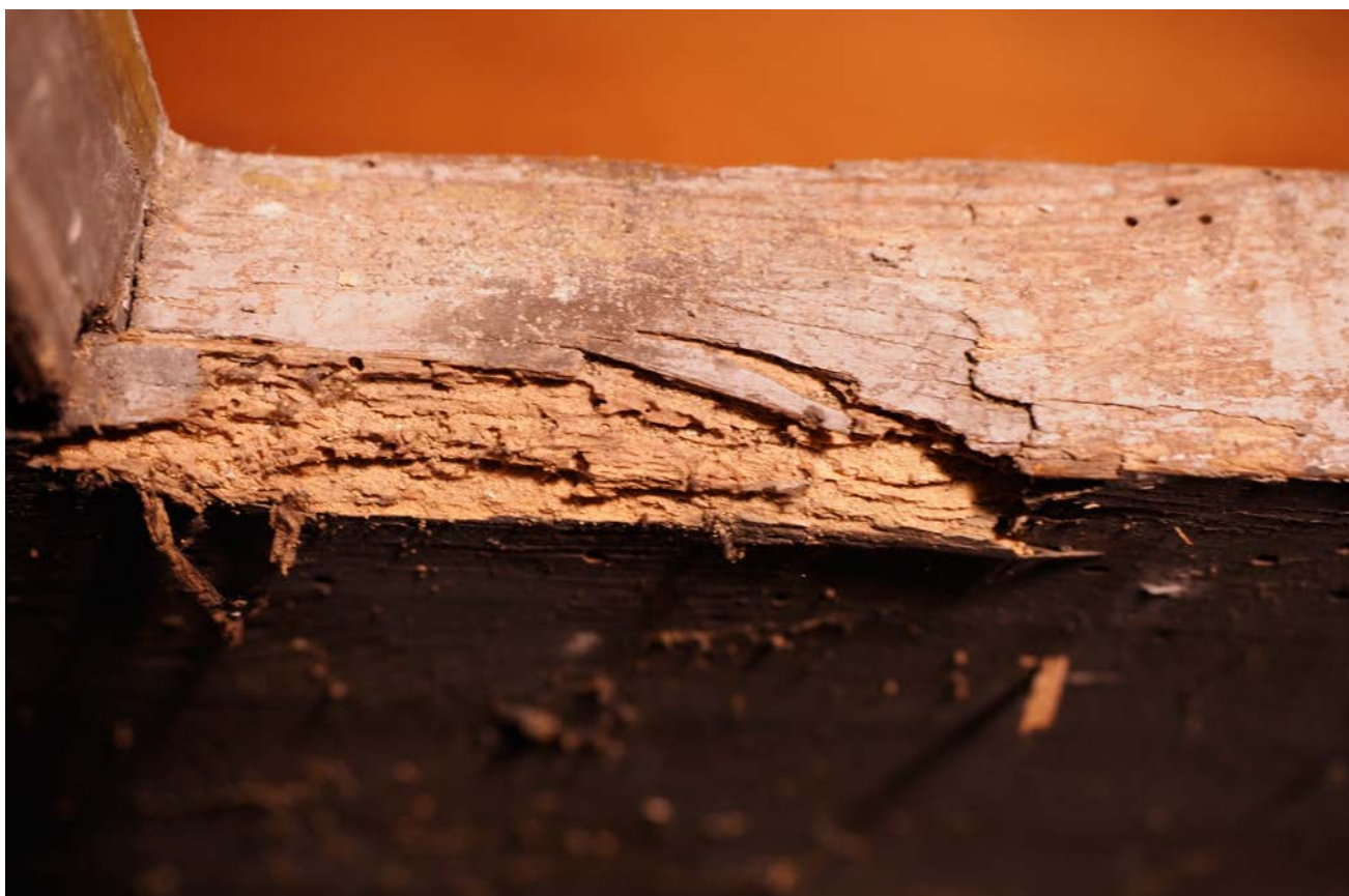
Lewa szafa organowa przed konserwacją, od środka, po demontażu instrumentu. Widoczny katastrofalny stan zachowania drewna zniszczonego przez drewnojady, wilgoć i mikroorganizmy.
