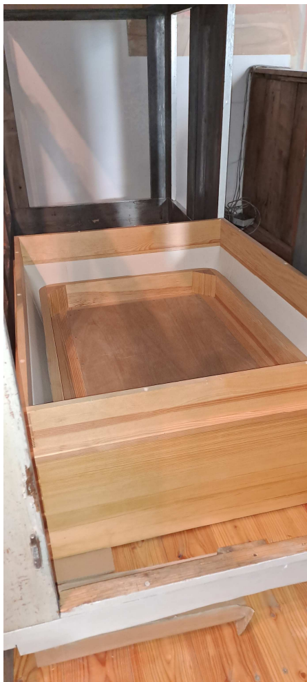
Montaż miecha we wnętrzu szafy organowej.
